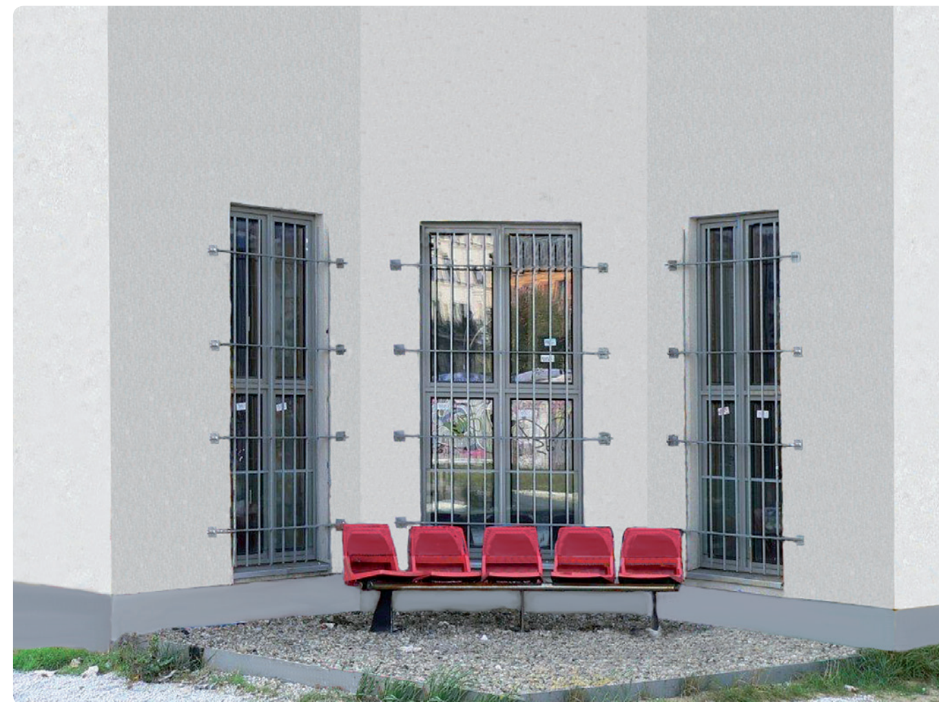
Na het reinigen met warm water onder hogedruk werd de graffiti volledig verwijderd
